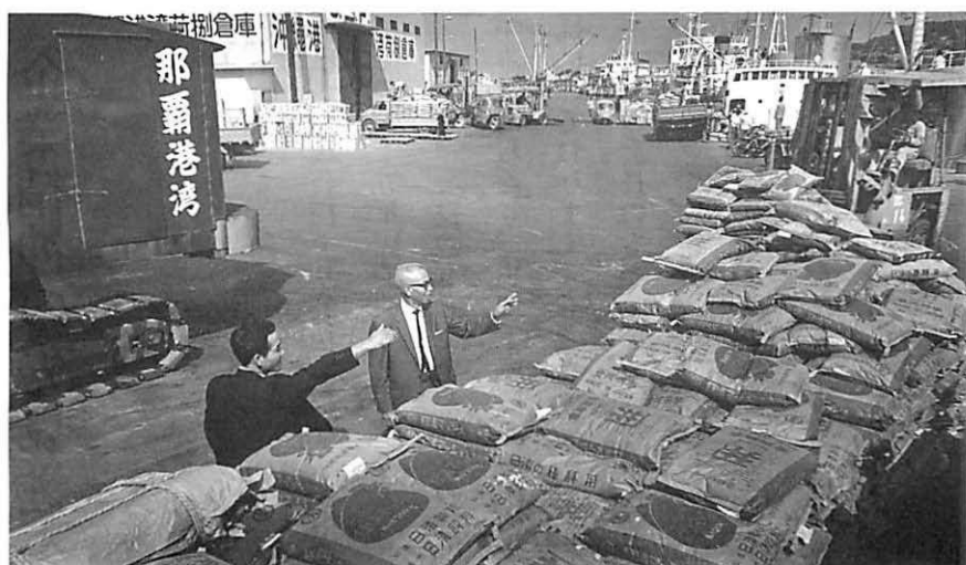
泊港荷揚げ場視察
