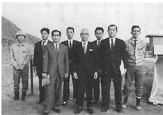
福地ダム建設現場
