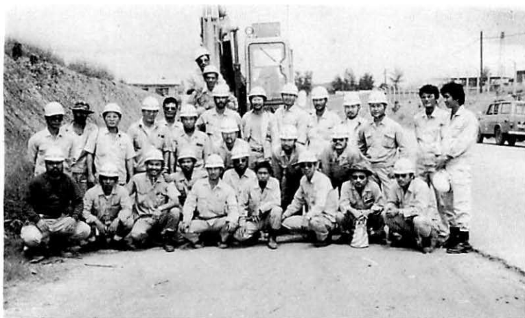
ナイゼリア共和国イバダン地に通信施設建設工事中の（株）大城組職員 （昭和54年）
